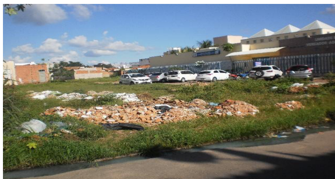
Figura 04. Principais RCDs do Ponto 02 - tijolos e concreto
