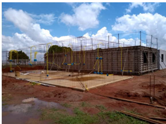
Figura 04. Embutimento de eletrodutos.
