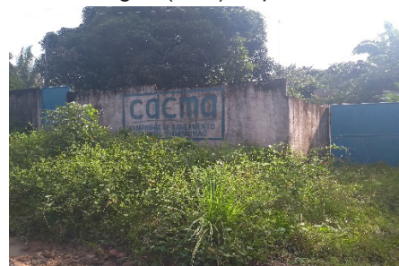
Figura 4: Estação de Tratamento de Água (ETA) Pepital.
