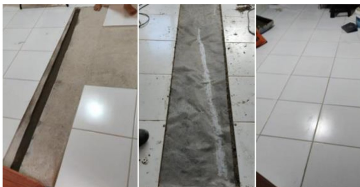
Imagem 1: Correção nas fissuras no piso.
