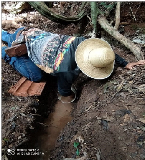
2C - Extração das raízes na tubulação.
