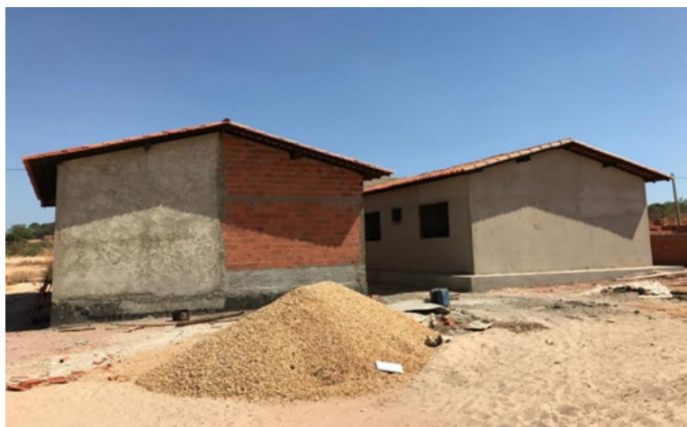
Figura 3. Foto das casas com a aplicação do reboco
